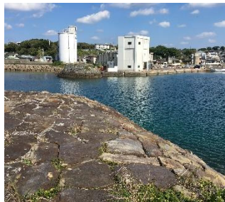
松寿院が造った築島突堤
