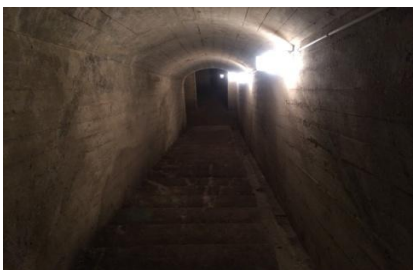
串良電信司令室地下壕跡
