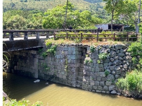
島津樋門と島津橋
